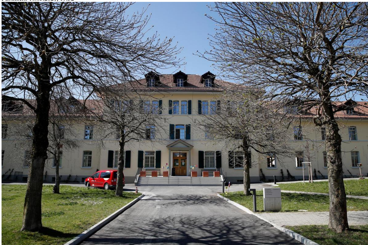
Die Renovationsarbeiten am Hauptgebäude des Heims wurden im Oktober 2020 abgeschlossen. Foto: Stefan Wermuth
